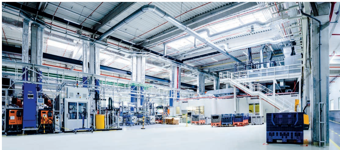
Interiér nové výrobní haly, foto: Varroc Lighting Systems
